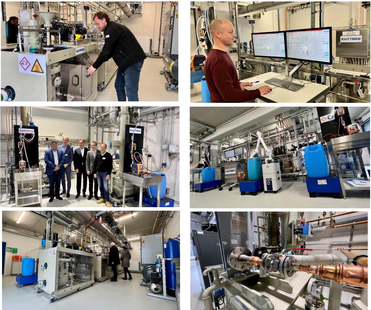
Abbildung 8 - Pilotanlage in der Dock3-Anlage, Industriepark Schwarze Pumpe, Sachsen, Deutschland
