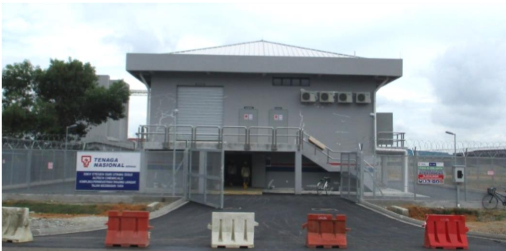
Bild 1: Fertiges Umspannwerk, HPA-Fabrikgelände
