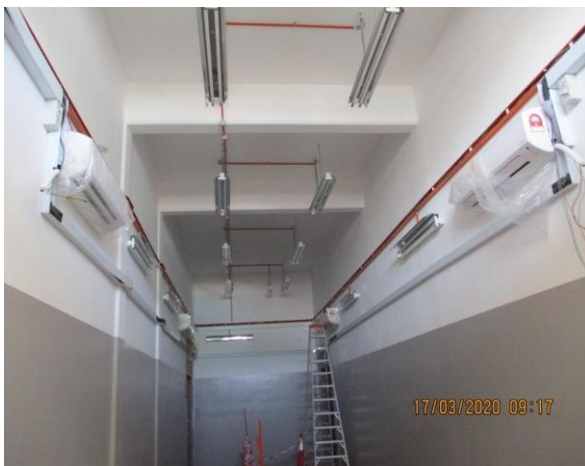
Abbildung 1 - Innenausbau des Umspannwerks
