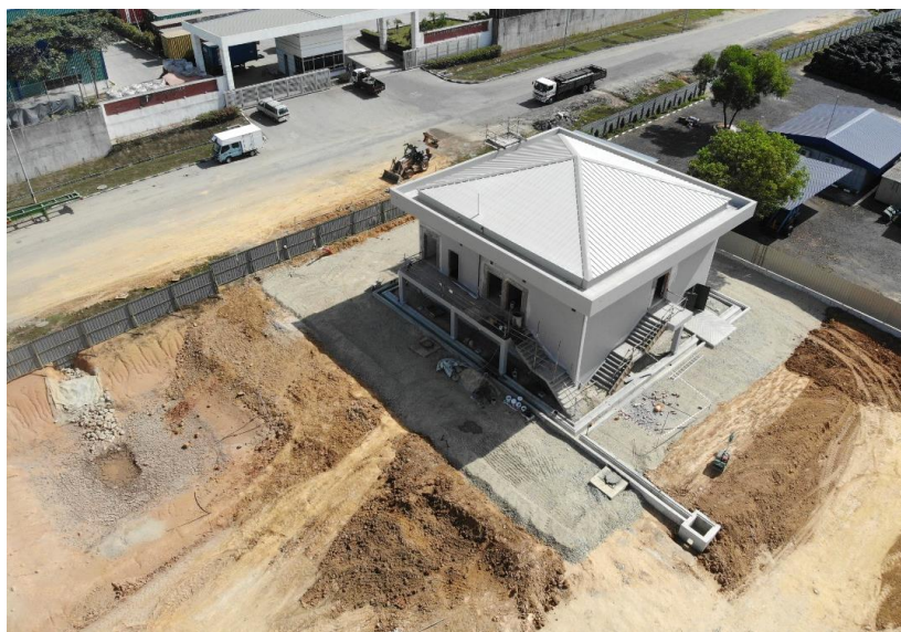
Abbildung 1 - Baufortschritt des elektrischen Umspannwerks März 2020 (Südwestliche Ansicht)
