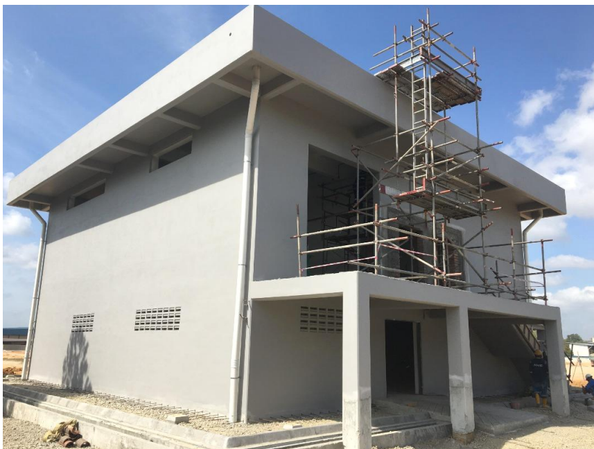
Abbildung 3 - Baufortschritt des elektrischen Umspannwerks März 2020
