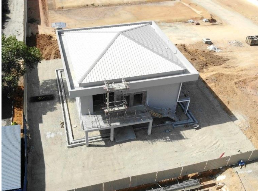
Abbildung 2 - Baufortschritt des elektrischen Umspannwerks März 2020 (Nördliche Ansicht)
