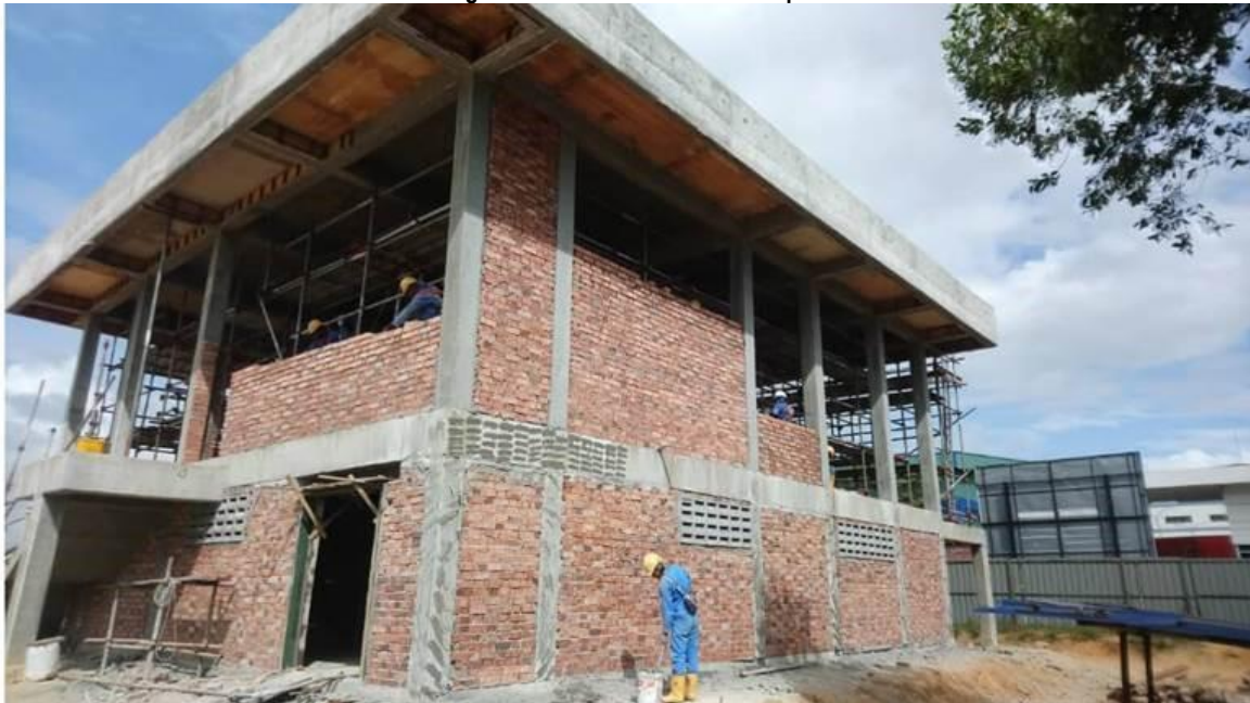
Abbildung 1 – Bau des elektrischen Umspannwerks
