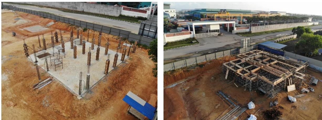
Abbildung 2 – Erste Arbeiten an der elektrischen Umspannstation, Dezember 2019
