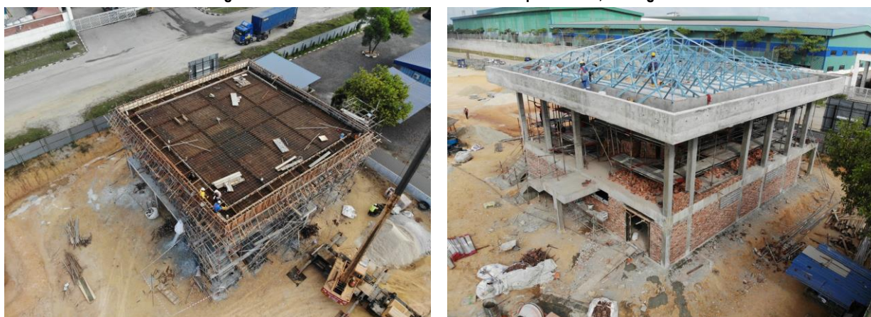
Abbildung 3 – Dachkonstruktion des elektrischen Umspannwerks, Anfang Januar 2020
